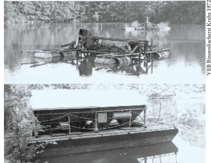
Intensive Teichwirtschaft mit Belüftungsanlagen und Futterautomat
